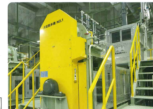
汚泥濃縮機・汚泥脱水機
