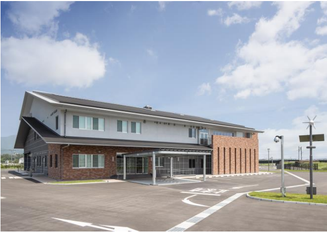
汚泥再生処理センター全景
