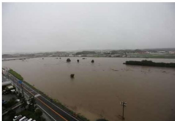
▲平成30(2018)年7月豪雨時の遠賀川(直方市役所前)
