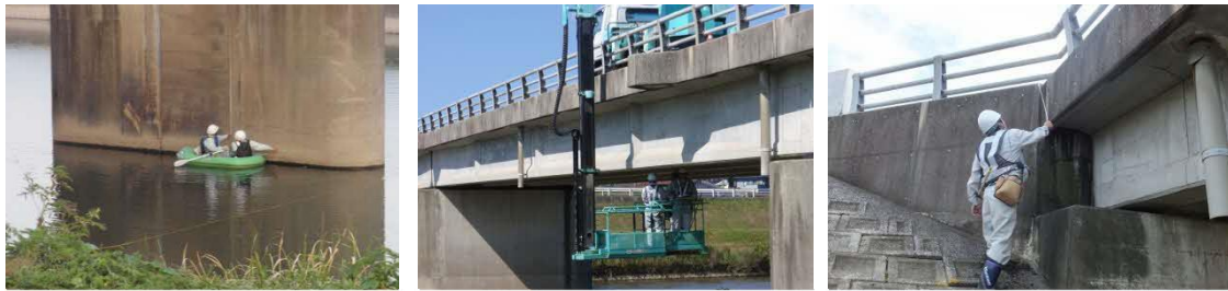
図-3 近接目視点検の様子
