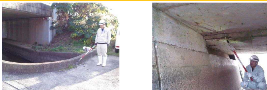
図-4 直営点検状況の様子
