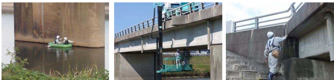
図-3 近接目視点検の様子
