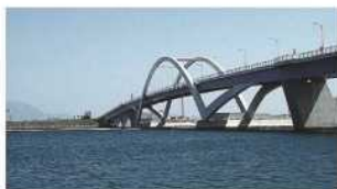
海の中道大橋(福岡市東区)
