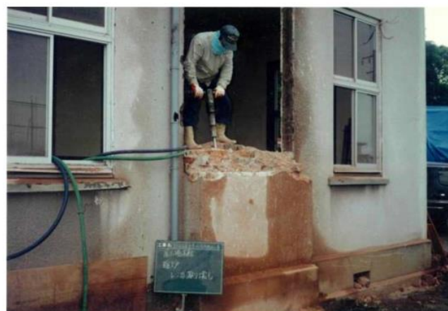
写真-77 東暖炉煉瓦取り壊し
