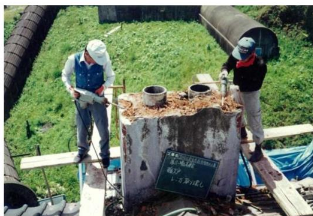
写真-76 南暖炉煉瓦取り壊し
