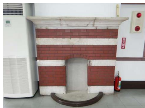
2 階マントルピース
