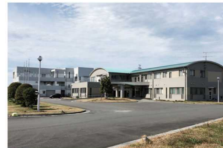
遠賀川中流浄化センター
