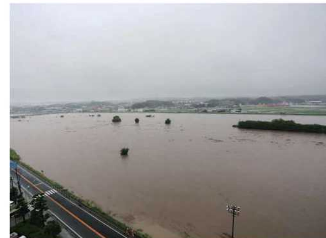
平成30 (2018) 年7月豪雨時の遠賀川 (直方市役所前)
