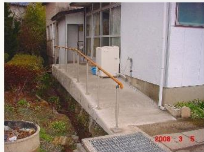
（施工後） 寝室までの外部アプローチ
