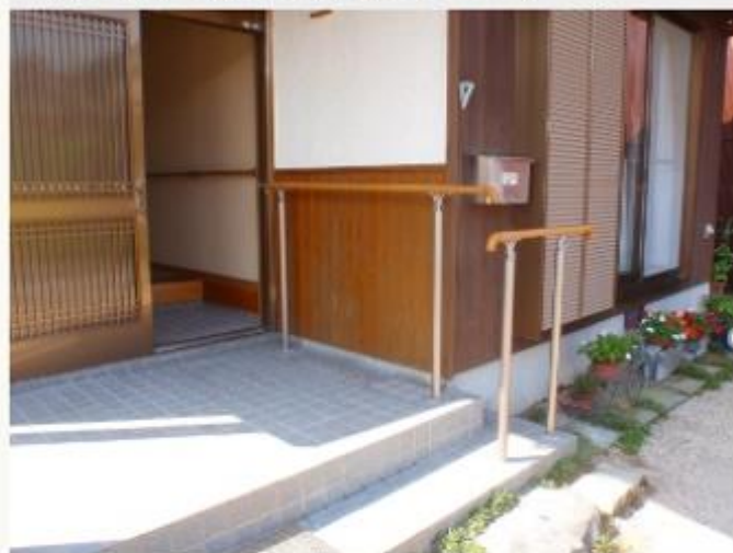
（施工後） 玄関出入口までのアプローチ
