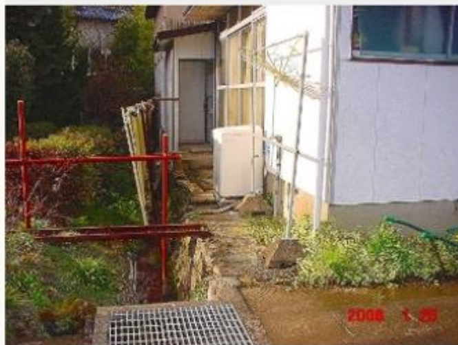
（施工前） 寝室までの外部アプローチ
