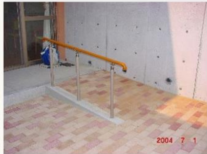
（施工後） 外部アプローチ
