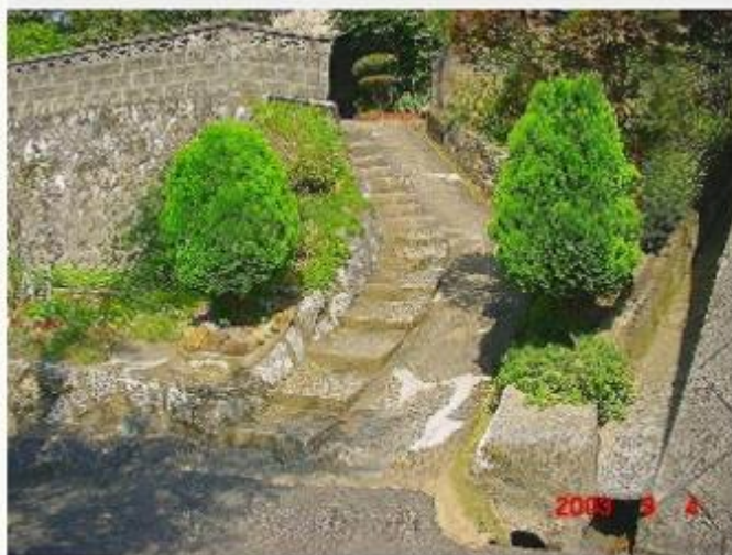
(施工前)道路から玄関までの長い階段アプローチ①
