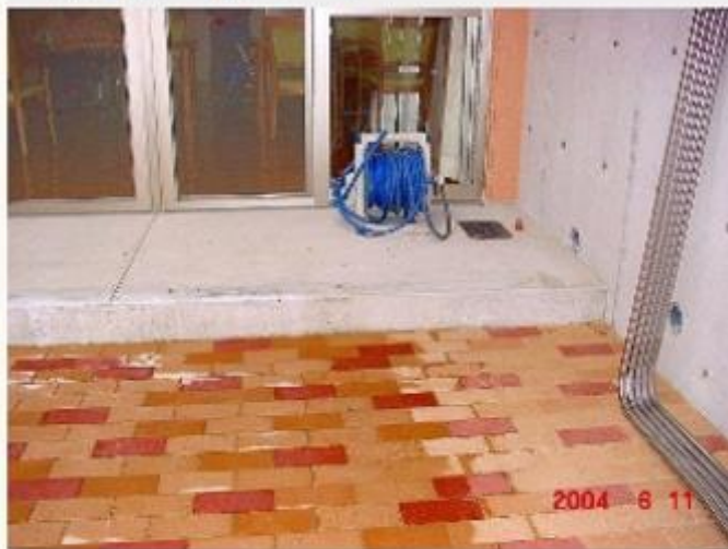
（施工前） 外部アプローチ
