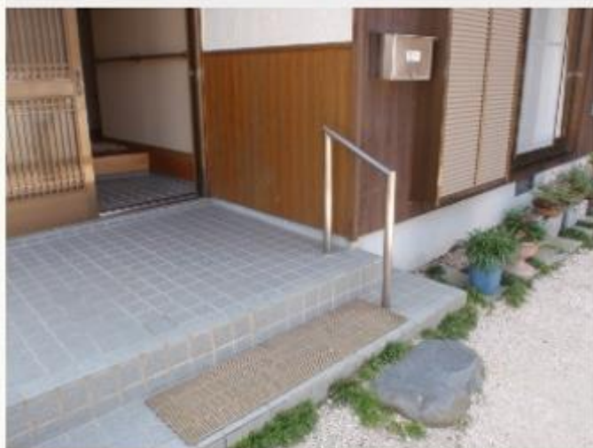
（施工前） 玄関出入口までのアプローチ
