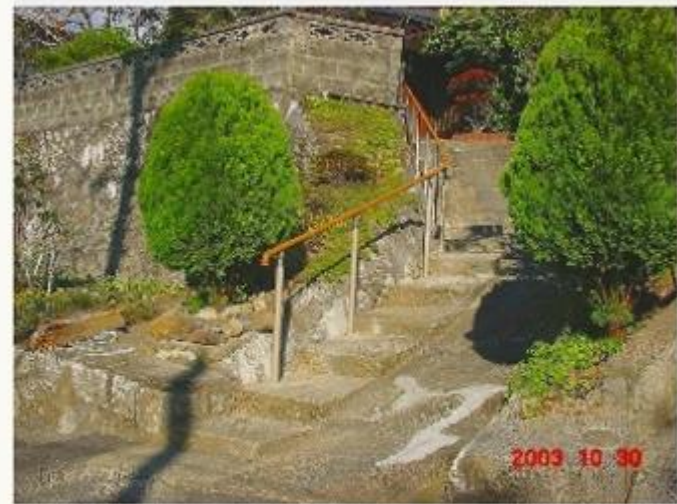
(施工後)道路から玄関までの長い階段アプローチ①
