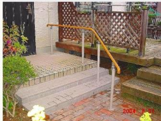
（施工後） ポーチからの玄関アプローチ
