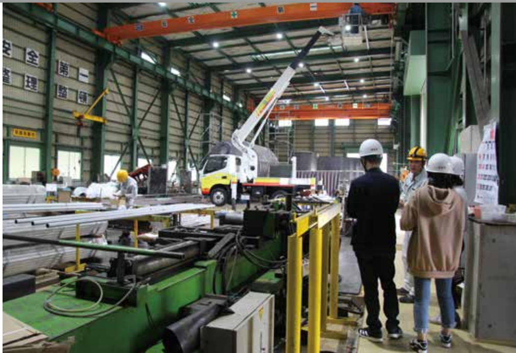
配管の製作工程について説明を受ける学生たち
