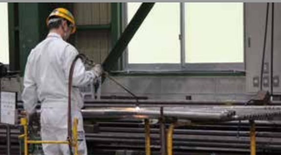
パイプを加熱して曲げる工程
