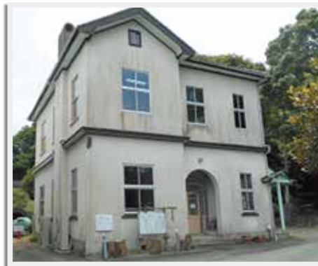
旧筑豊石炭鉱業組合直方会議所 (石炭記念館本館)
